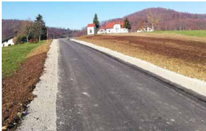
Rekonstrukcija lokalne ceste Gubno-Zg. Krivica 1
