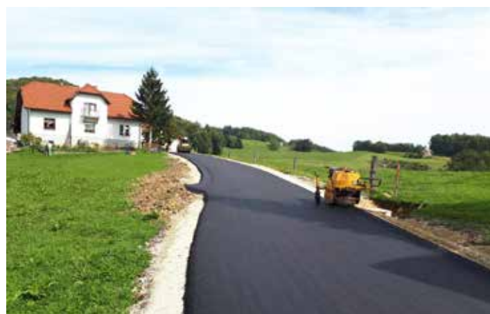
Rekonstrukcija lokalne ceste Gubno-Zg. Krivica 2
