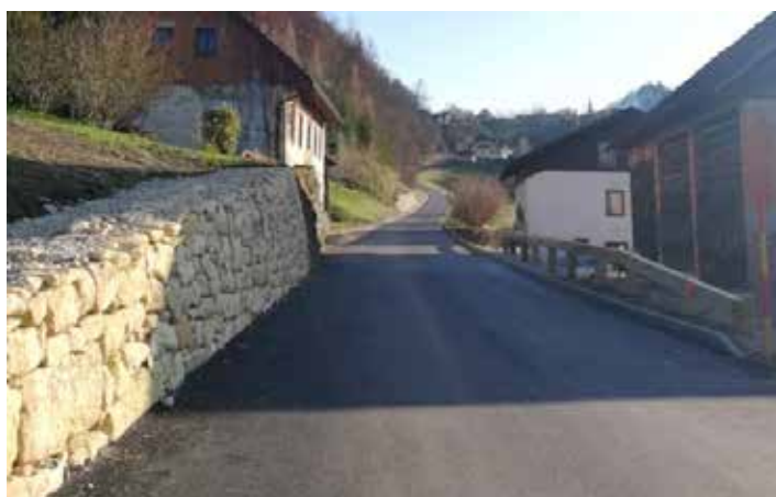
Rekonstrukcija lokalne ceste Stari trg– Pilštanj-Drenik 1
